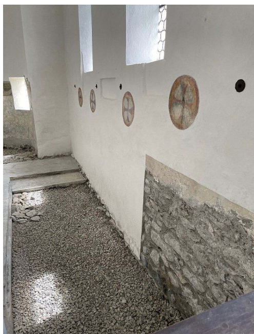
freigelegtes romanisches Mauerwerk, das in Zukunft sichtbar bleibt, Bild, Pfarre Kals
